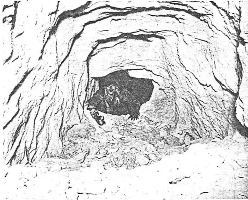
Die „weiße Kohle“ der Steiermark: Die Durchschlagsstelle im 5320 Meter langen Stollen des Leigitschlammkraftwerkes. — Der Durchbruch der letzten Trennungswand erfolgte durch Dynamitexplosion, die Bundespräsident Dr. Hainisch durch Druck auf einen elektrischen Knopf zur Entladung brachte.
