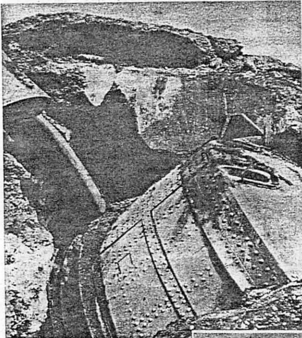
Ein Bild aus dem Fort Loucin der Festung Lüttich; durch die furchtbare Wirkung des deutschen 42-cm-Mörzers wurden die stärksten Panzerplatten durchbrochen.
