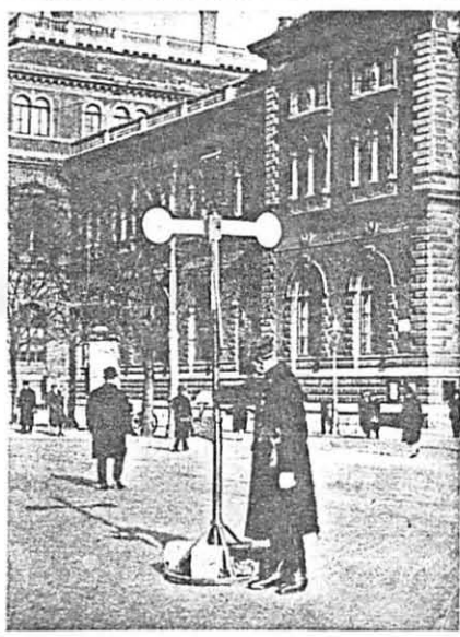
Der neue Verkehrsregulator an der Wollzeile in Wien. An der Kreuzung Wollzeile-Parkring wird jetzt ein mechanischer Regulator ausprobiert, welcher die Hand- und Armssignale des Wachmanns wirksam ersetzt. Phot. Ernst & Gebauer, Wien.
