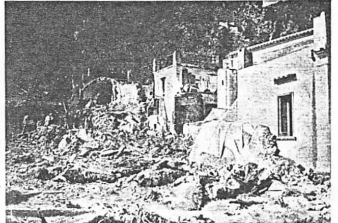
Die Erdlawinenkatastrophe von Amalfi: Zerstückte Wohnhäuser, in denen nach den Leiden der Verschütteten gesucht wird. Nach einer photographischen Aufnahme.
