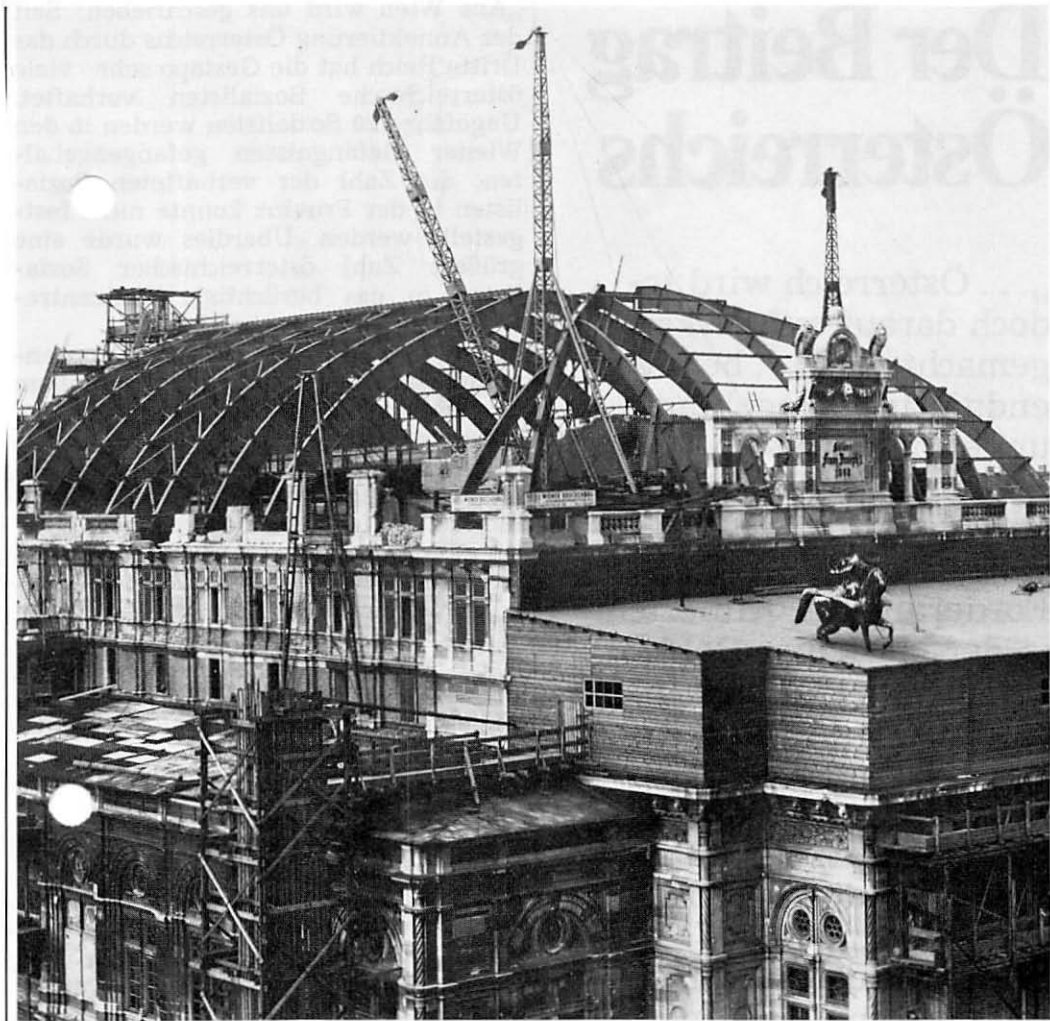
Die folgenden Jahre sind durch den Wiederaufbau gekennzeichnet (Bild: Wiener Staatsoper, Juni 1949), der bereits 1945 begonnen hatte und im wesentlichen neun Jahre später, 1954, abgeschlossen werden konnte.
